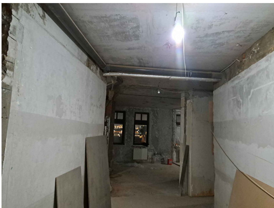
Фото 2. Общий вид коридора (комн. 10)
