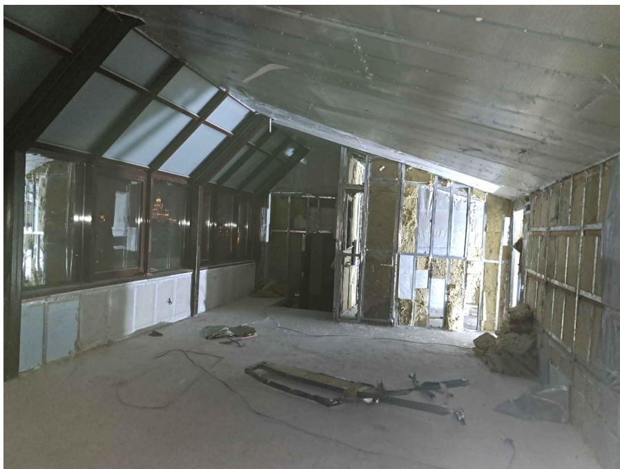
Фото 1. Общий вид надстройки (комн. 1)
